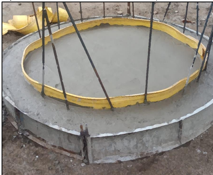
Esquema 1 – Instalación de Banda Termoplástica de PVC.
